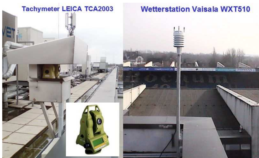
Abb. 4: Installationsorte des Tachymeters und der Wetterstation
