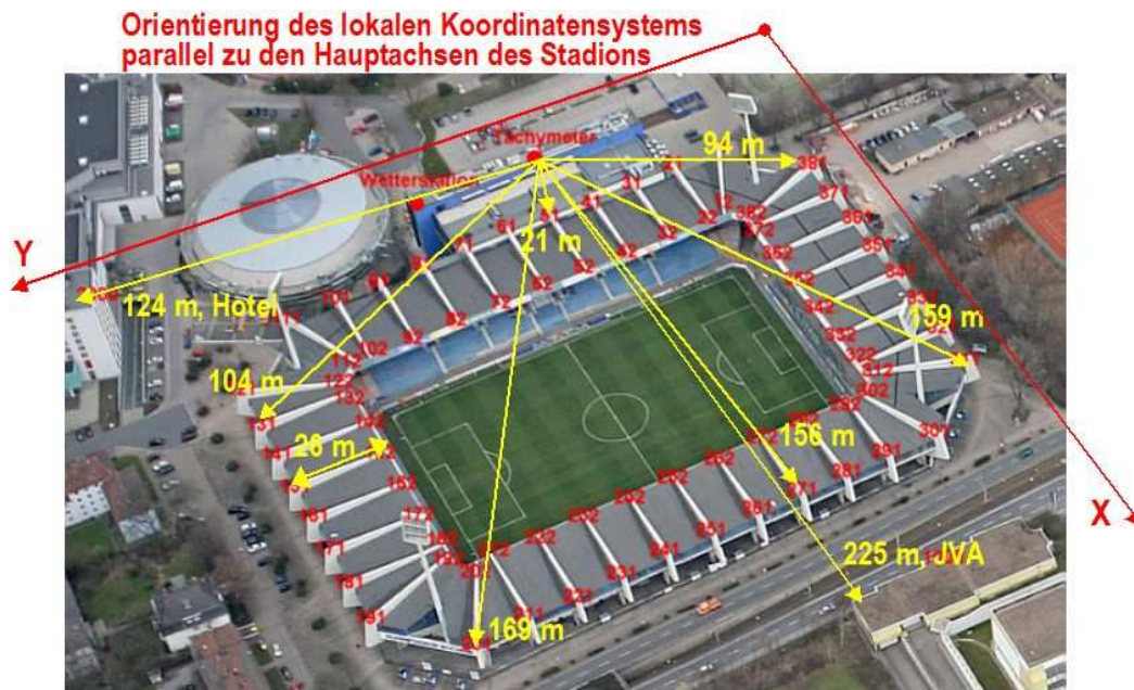
Abb. 3: Installationsorte und Entfernungen des 3D-Messsystems
