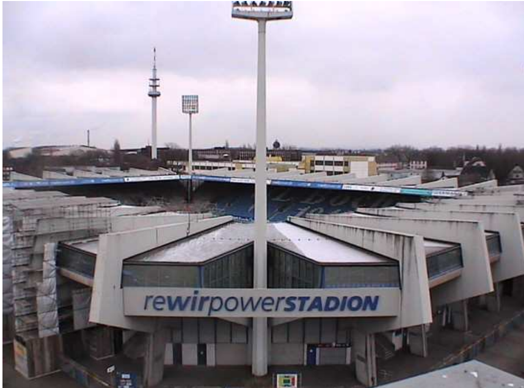
Abb. 1: Das rewirpowerSTADION des VFL Bochum mit den 38 Spannbetonbindern
