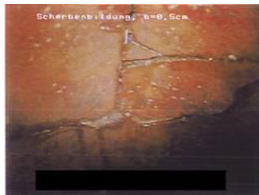
Abbildung 2: Schadensbilder a) vertikale Lageabweichung b) Scherbenbildung
