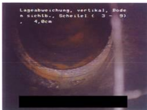
Abbildung 2: Schadensbilder a) vertikale Lageabweichung b) Scherbenbildung
