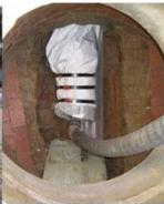
Geschlossen Erneuerung mittels Liningverfahren (Bilder: IKT)
